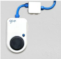
Falls aufgrund der örtlichen Gegebenheiten erforderlich, zusätzliche Versorgungsleitung verlegen. Bei der Auslegung des Querschnitts der zusätzlichen Versorgungsleitung ist insbesondere die Verlegeart zu beachten. Wir empfehlen nachfolgende Kabelquerschnitte, jedoch muss die Elektrofachkraft entsprechend der lokalen Situation entscheiden:
